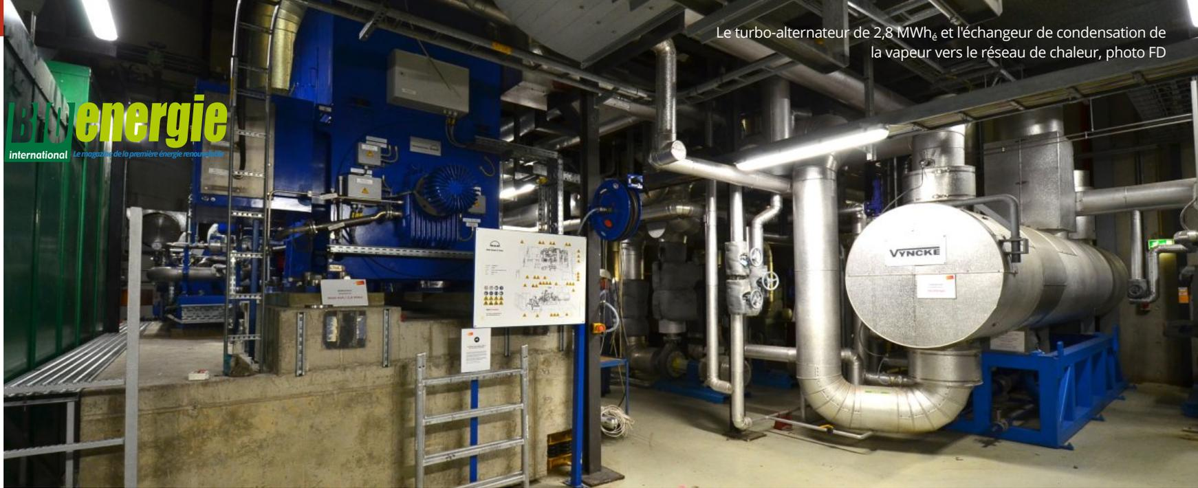
Le turbo-alternateur de 2,8 MWh<sub>e</sub> et l'échangeur de condensation de la vapeur vers le réseau de chaleur, photo FD
