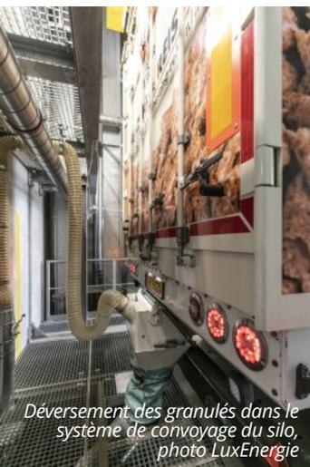
Déversement des granulés dans le système de convoyage du silo, photo LuxEnergie
