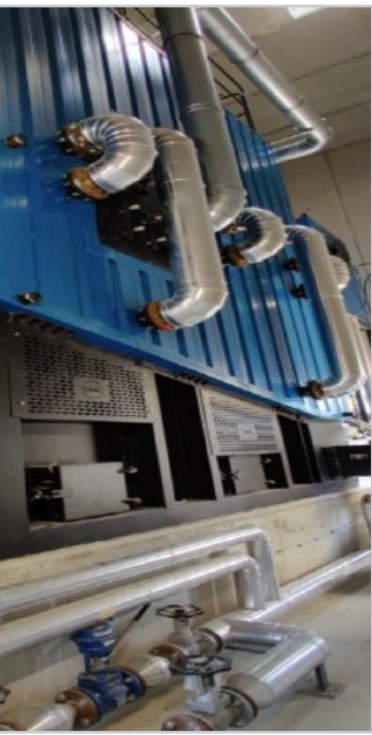
La chaudière LSolé-Series de Sigean avec ses circuits de recyclage d'air, photo Vyncke
