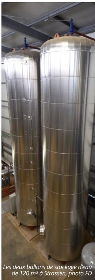
Les deux ballons de stockage d'eau de 120 m<sup>3</sup> à Strassen, photo FD
