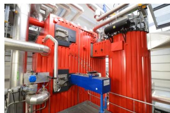
La partie radiative de la chaudière à gauche avec son ramoneur vapeur et l'échangeur à tubes de fumée à droite avec son ramoneur pneumatique, photo FD
