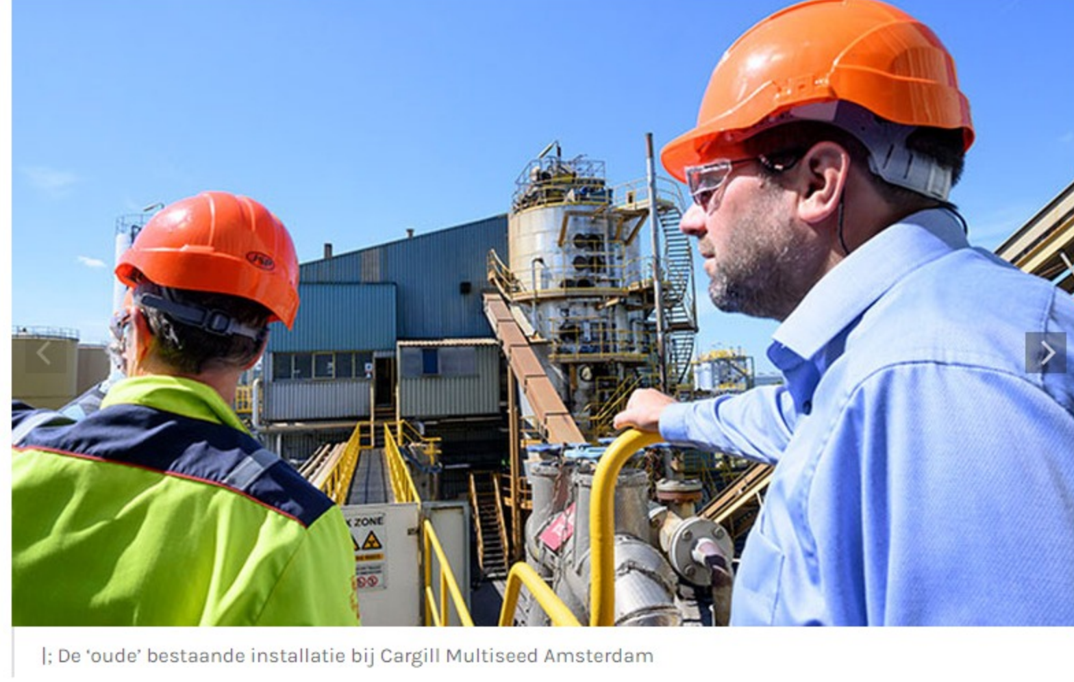
I: De 'oude' bestaande installatie bij Cargill Multiseed Amsterdam
