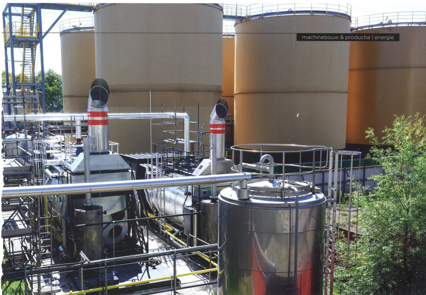
▲ De nog relatief nieuwe gasgestookte 'tijdelijke' ketels
